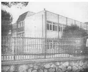
scuole elementari sede centrale di Palombara Sabina
