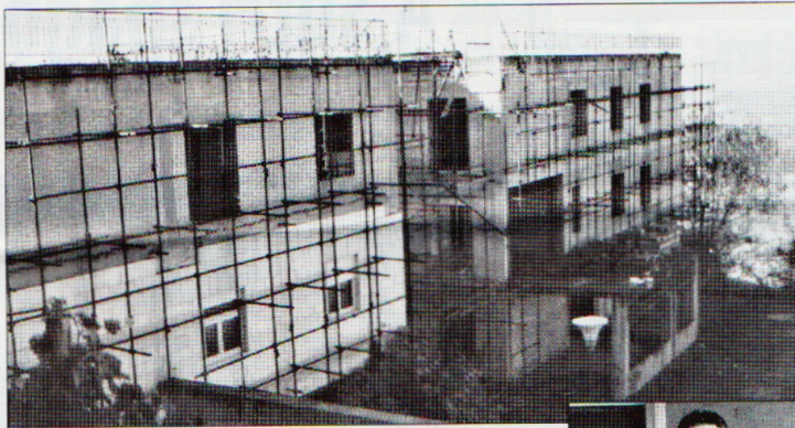
nelle foto: in alto i ponteggi dell'ala in costruzione dell'ospedale; a fianco Francesco Cesi, sindacalista della Fase
